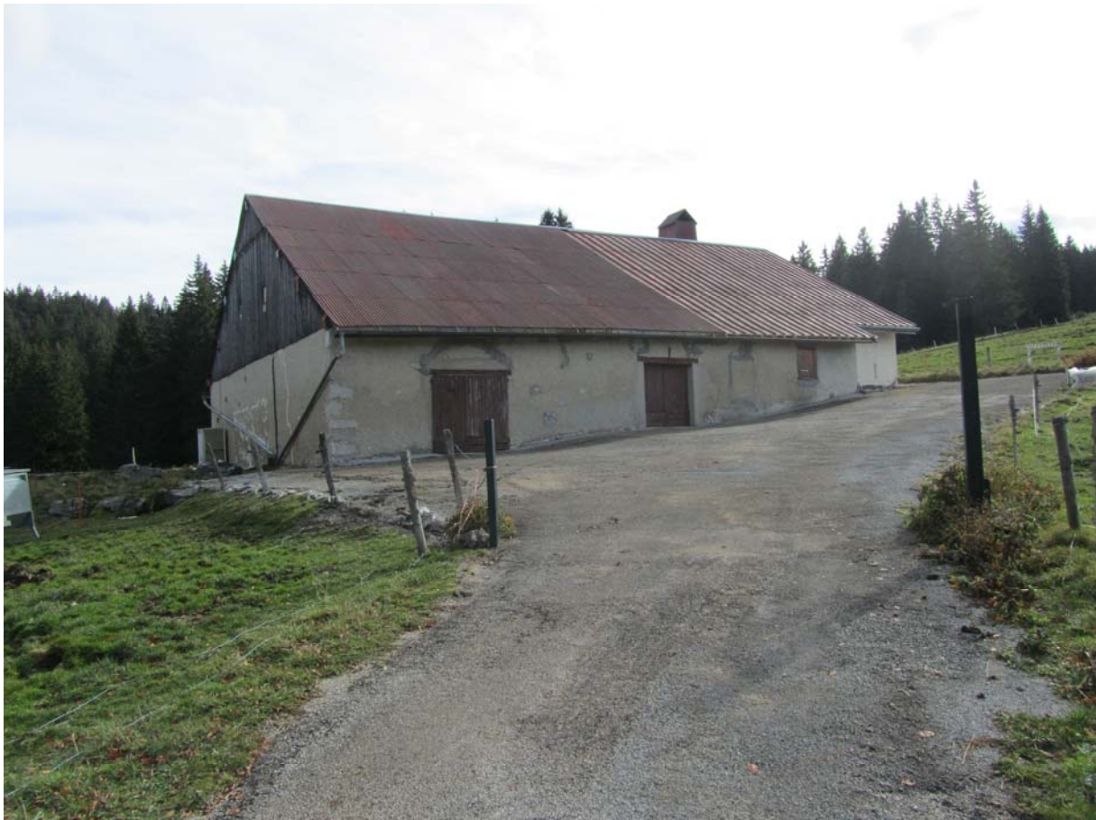
La Béchette, côté vallée. De là on peut apercevoir le toit gris-bleu de la Laisinette-dessus.
